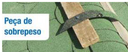
Para uma melhor fixação das peças de cumeeira – instaladas tanto no espigão, quanto na cumeeira – que fiquem levantadas, podem ser temporariamente colocadas peças com a função de sobre peso, feitas na própria obra, em forma de cela de cavalo.
