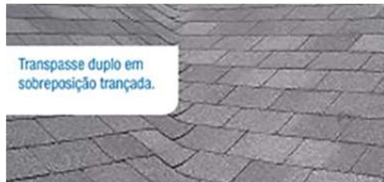
Após a instalação de proteção do eixo da água furtada, as fiadas são instaladas intercalando-se e sobrepondo-se até chegarem ao ponto mais alto da cobertura.
