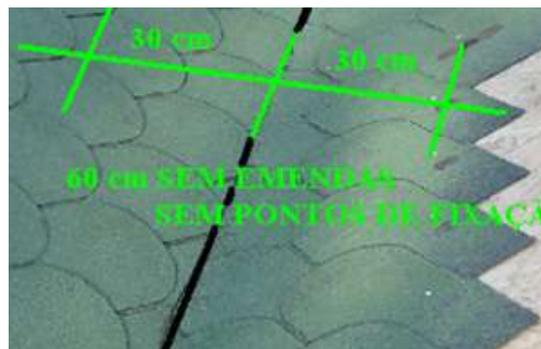
A fixação das telhas deve ser feita de modo que os pontos de fixação fiquem pelo menos 30 cm afastados do eixo da água furtada, evitando infiltrações.
