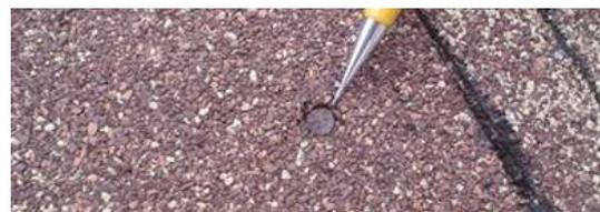
Sob nenhuma hipótese poderão ficar aparentes pregos ou pontos termoadesivos. Isso é um erro de instalação que pode ocasionar pontos de infiltração.
