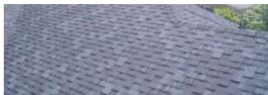
A instalação segue praticamente as mesmas recomendações do espigão. Primeiramente, há um transpasse de telhas de um dos panos para o outro, e depois, no outro pano, as telhas são cortadas no eixo, sendo posteriormente instaladas as peças de cumeeira como acabamento.
