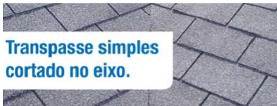
Após a instalação de proteção do eixo da água furtada, as telhas são instaladas primeiramente em um dos panos, até chegarem ao ponto mais alto da cobertura, transpassando para um dos lados pelo menos 30 cm – contados a partir do eixo da água furtada – formando-se uma linha paralela ao eixo.
