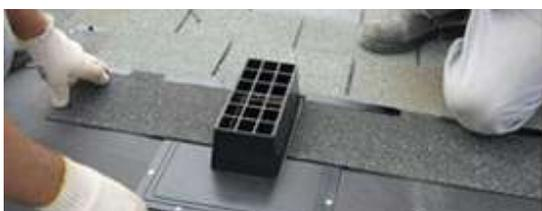
4. Fixar a peça com pregos nos pontos indicados (furos). Obs.: A peça possui canais para escoamento de água que devem estar direcionados com a abertura para baixo.
