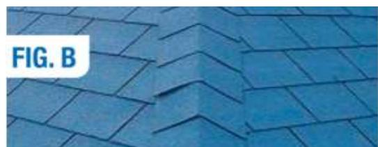
As telhas transpassam em um dos lados (Fig. A), e, no outro pano da cobertura, as telhas são cortadas no eixo do espigão. Em seguida, são instaladas as peças de arremate, que devem ser alinhadas e assentadas com cuidado para não rachá-las (Fig. B).
