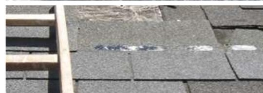
Telha arrancada com a ação do vento, devido à fixação inadequada
