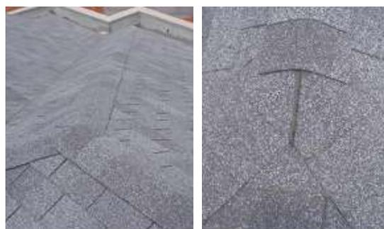
Nas interseções triplas, a peça de arremate deverá ser recortada, alinhada e assentada com muita atenção e cuidado, utilizando-se apenas o adesivo asfáltico.
