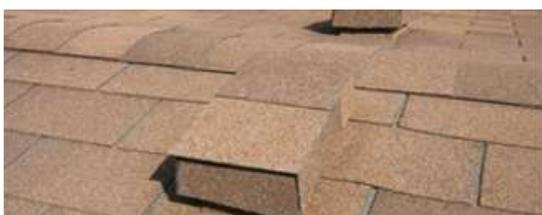
6. Revestir com telhas a capa que cobre a abertura da peça do aerador especial. Utilizar adesivo asfáltico.
