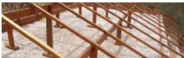
Estrutura pontaletada sobre a laje e sem tesouras.
