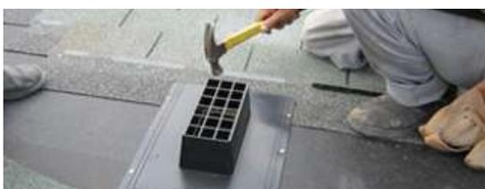
3. Na base do aerador, aplicar adesivo asfáltico
